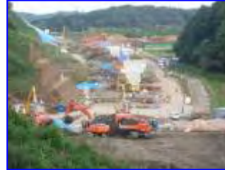
印旛村地区高架橋工事
