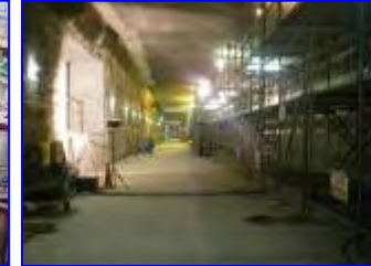
空港第2ビル内増築工事
