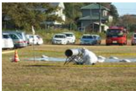
【漏洩場所応急処置】
