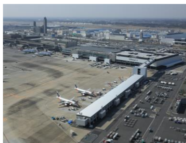
成田国際空港 第3旅客ターミナルビル
