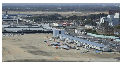
成田国際空港駐機場
