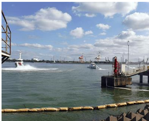
海面拡散放水(場所:3号栈橋)
