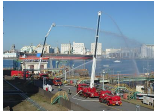
陸上からの一斉放水
