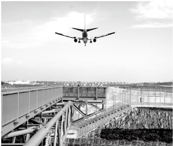
架けての設置である。北側の進入灯はこれまで660mだったが、標準仕様の900mとしたことで、着陸最低気象条件が改善された。空港には霧などの悪天候でも航空機が正確に進入コースにのって安全に着陸できるようILSが設置されており、航空保安施設の整備・運用状況により、着陸最低気象条件はCAT Iから最高レベルのCAT IIIに分類されている。B滑走路はCAT Iでの運用となっており、北側からの進入についてはこれまで滑走路視距離が700mないと着陸できなかつたが、今回の進入灯の整備により、滑走路視距離が550mあれば着陸できるようになった。
