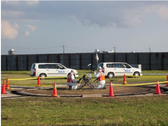
応急処置作業
